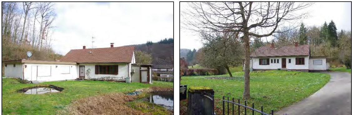
Abb.: Wohnhaus Ansicht Rückseite (l.) und Ansicht Vorderseite (r.)
