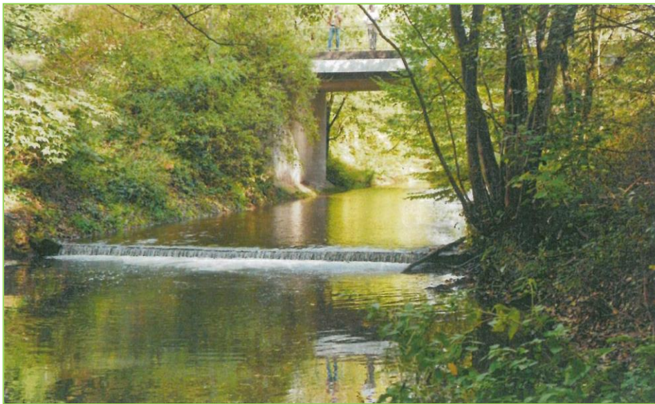
Abb.1: 2013 bestehende Sohlschwelle (Blick gegen die Fließrichtung)
